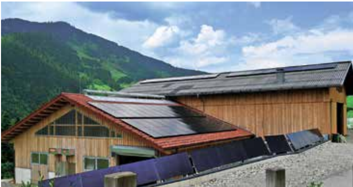
NICHT NUR AM DACH findet sich eine PV-Anlage, die Platten dienen auch als Zaun und Absturzsicherung. „In eigene Energie zu investieren war uns wichtig.“
