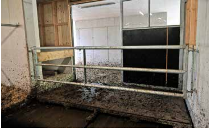
FÜR DEN ABWURF DER ZWEI SCHRAPPERBAHNEN wurde das Gebäude um einen Vorsprung erweitert.
