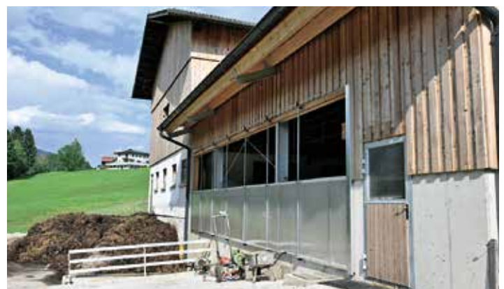
BEIDSEITIGE Hebefenster und Firstentlüftung sorgen für optimale klimatische Bedingungen im Stall.
