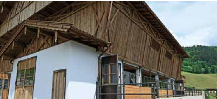
Der Abwurf der Schraperbahn in den Querkanal erfolgt außerhalb des Laufgangs im Bereich des Zubaus.
