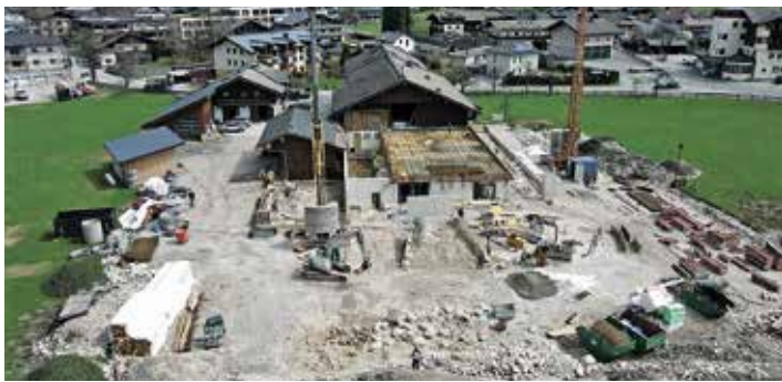
BAUPHASE im Frühjahr 2022
