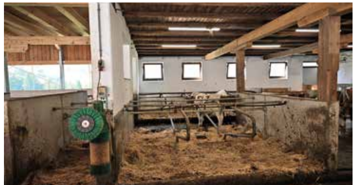
DER ÜBERGANG VON ALT AUF NEU: Das Altgebäude zu sanieren war das größere Unterfangen als der Neubau. Im Bild die neuen Lärchenunterzüge.
