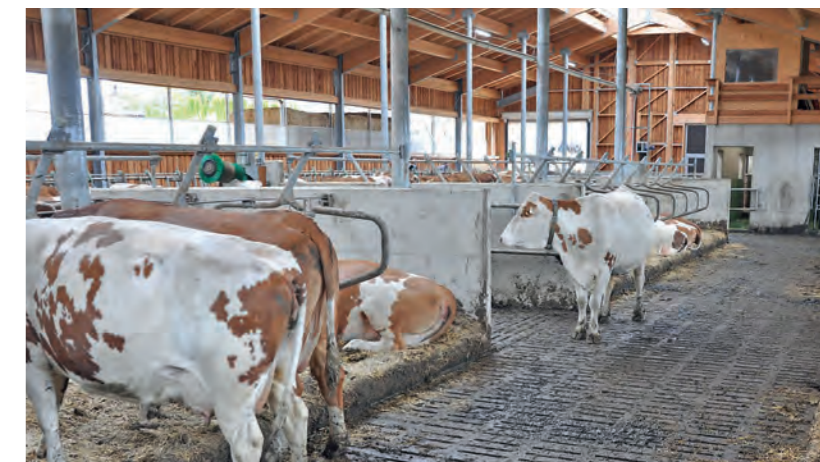
EIN TEIL DER HALLE ist aufgrund der Hanglage unterkellert (Güllerraum 810 m³). Im Fress- und Laufgangbereich fährt ein Schrapper.
