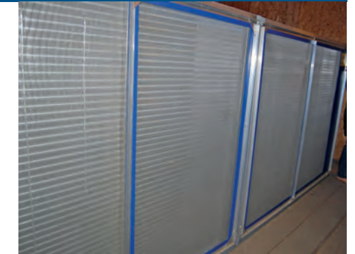
Bei länger dauerndem Schlechtwetter besteht bei der Kaltbelüftung mit Dachabsaugung keine Sicherheit zum Erreichen der Lagerfähigkeit des Heus. Eine Lösung ist die zeitweise Nutzung einer Lufterwärmung per Warmluftofen oder Wärme aus einer bestehenden Heizanlage mithilfe eines Wärmetauschers, ebenso der Einsatz eines Luftentfeuchters.
