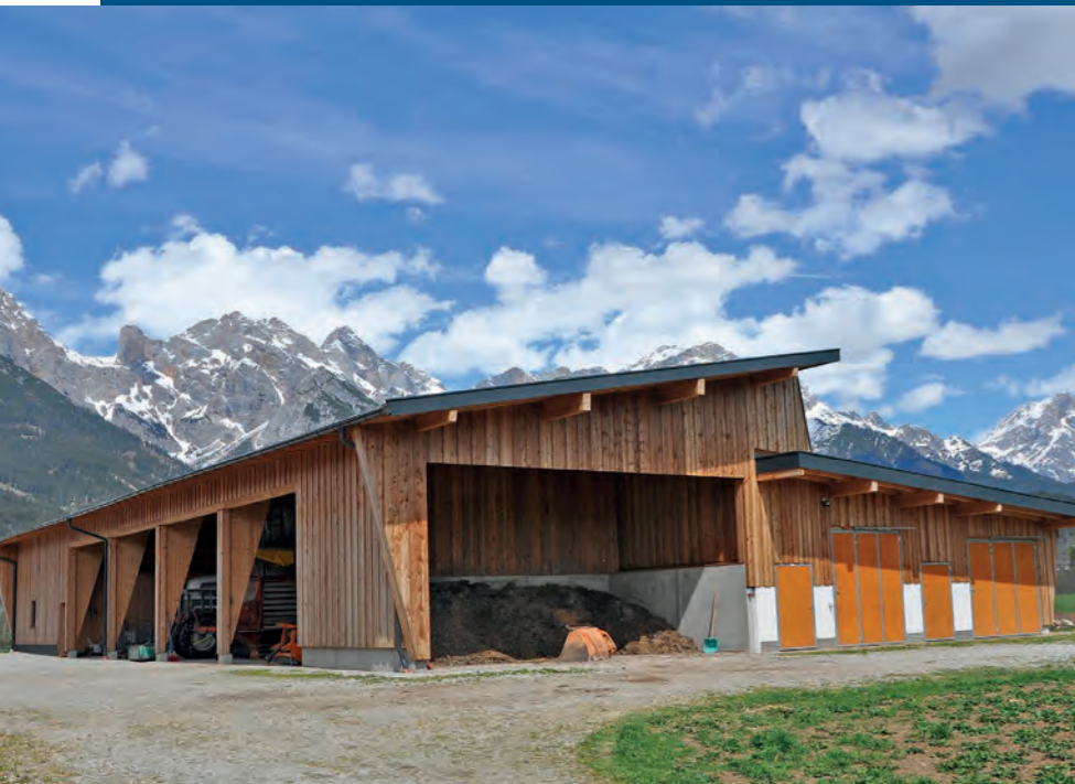
DIE MISTLAGERSTÄTTE ist überdacht, damit keine Geruchsbelästigung entsteht. Nach der Ablage vom Kotförderband wird der Kot mit dem Frontlader auf die Lagerstätte gebracht.
