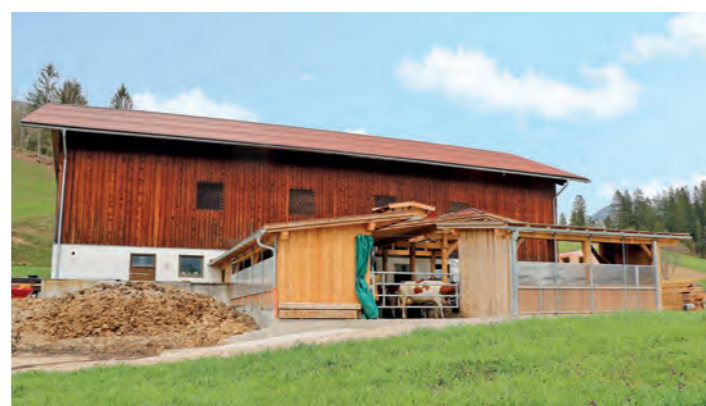
SCHIEBEFENSTER UND EIN WINDFANGNETZ sorgen bei schlechter Witterung für ein zugluftfreies Stallklima.
