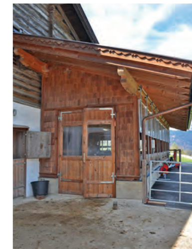
ANBAU IN HOLZRIEGELBAUWEISE: Das Holz stammt aus den eigenen Wäldern und im Kleinsägewerk am Hof ist das Bauholz entstanden. Der langjährige Zimmerer und begeisterte Schafzüchter Hannes Hettegger hat den Bau umgesetzt.
