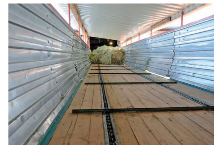
BESONDERE SORGFALT und auch einiges an Arbeitszeit kostete die Verlängerung und Verbindung der Führungsschienen sowie der Einbau der Ketten mit den Kratzbodenleisten.
