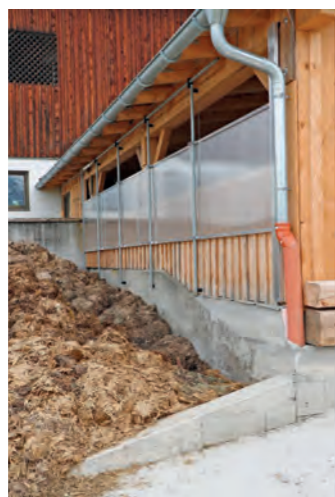
AUF EINER SEITE DES ZUBAUS wurde die bestehende Betonwand des Festmistlagers im Neubau integriert.
