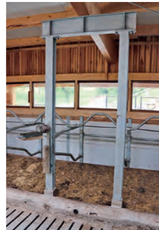
EINE PLATZSPARENDE LÖSUNG: Durch eine H-Säule konnte eine weitere Liegebox eingerichtet werden.
