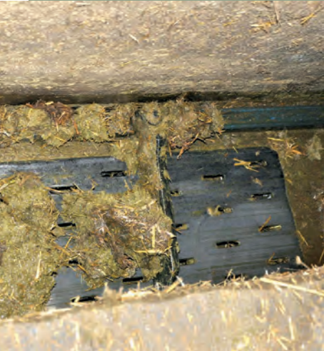
UM FESTMIST ZU ERHALTEN, wird im Querkanal die Jauche über einen Gitterrost in die Grube abgesondert.
