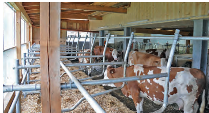
DER NEUE MILCHVIEHSTALL hat elf Tiefstreuliegeboxen und ist besonders hell. Den größten Teil der Stalleinrichtung lieferte die Firma Wölfleder.
