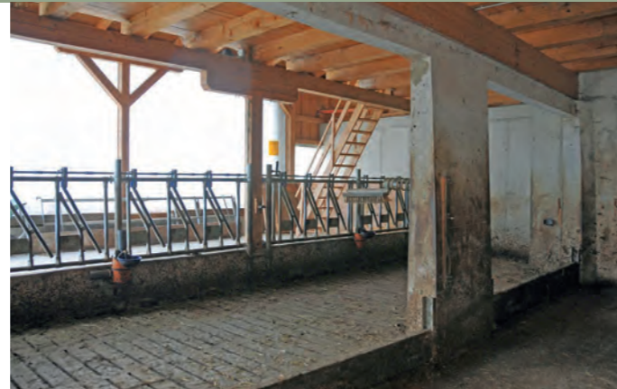
FÜR DEN KALBINNENSTALL wurde ein überdachter Fahrsilo genützt. Die betonierte Seitenwand wurde aufgeschnitten, von der Firma Fernsebner der Unterbau gemacht und eine Holzdecke eingezogen. Das Obergeschoß wird als Stroh- und Futterlager genützt, der einfache Abwurf erleichtert die Arbeit.
