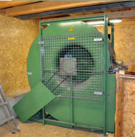
IN ZWEI HEUBOXEN erfolgt die Heutrocknung mittels Dachabsaugung und der Trocknungstechnik der Firma Lasco.
