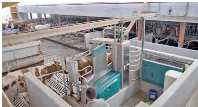
DAS ZENTRUM IM STALL IST DER GEA DairyRobot R9500. Die Besonderheiten sind die kompakten Abmessungen, der Zugang zum Euter oder das viertelindividuelle Melken. Der Roboter selektiert die Kühe in die jeweiligen Gruppen.
