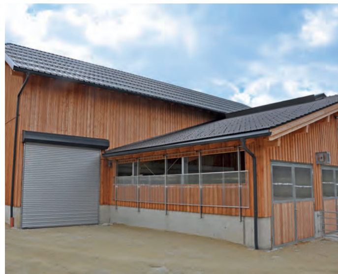
DIE DURCHFAHRT im hinteren Teil des Wirtschaftsgebäudes ermöglicht eine schlagkräftige Heuernte und ist sehr praktikabel. Auch das Heu wird in diesem Bereich abgeworfen und von dort auf den Futtertisch geschoben.
