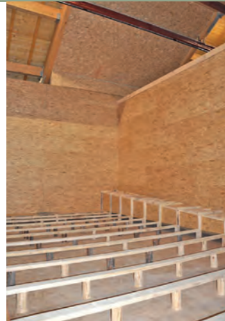
IN ZWEI HEUBOXEN erfolgt die Heutrocknung mittels Dachabsaugung und der Trocknungstechnik der Firma Lasco.
