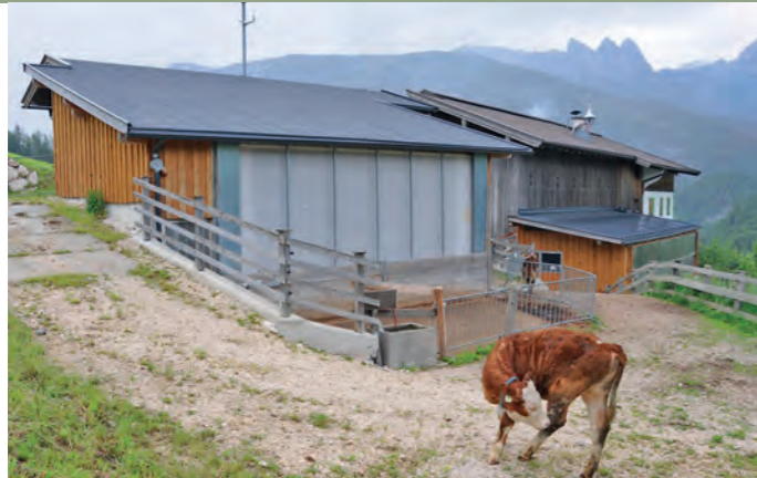
FÜR DEN KALBINNENSTALL wurde ein überdachter Fahrsilo genützt. Die betonierte Seitenwand wurde aufgeschnitten, von der Firma Fernsebner der Unterbau gemacht und eine Holzdecke eingezogen. Das Obergeschoß wird als Stroh- und Futterlager genützt, der einfache Abwurf erleichtert die Arbeit.
