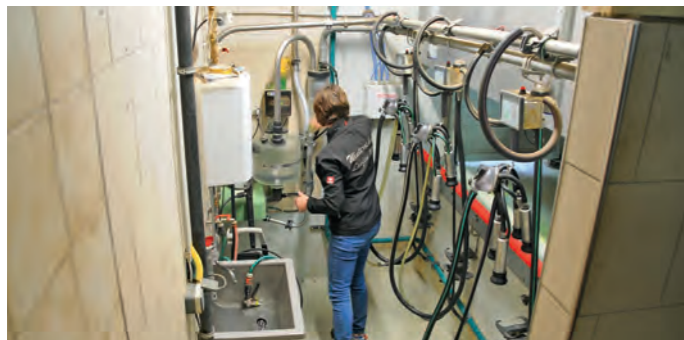
DER DREIER-SIDE-BY-SIDE-MELKSTAND war platztechnisch die einfachste Lösung, die Melktechnik wurde von der bestehenden Rohmelkanlage übernommen. Die Kosten sind damit im Rahmen geblieben, der Arbeitskomfort ist deutlich gestiegen.
