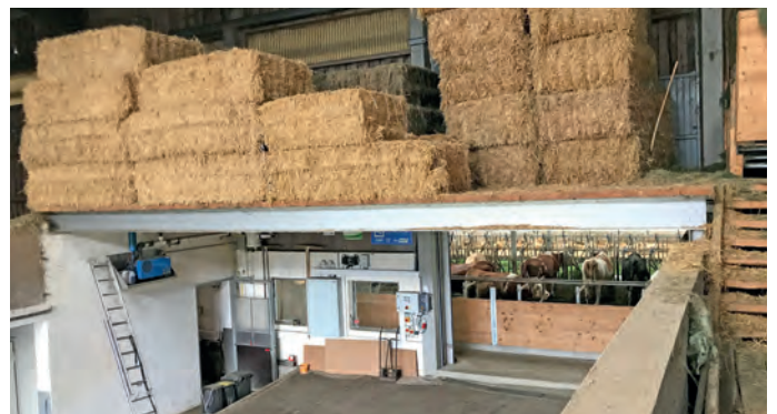
DER ÜBERGANG ZUM NEUEN STALL ist überdacht. Die eingezogene Decke dient als Strohlager. Auf der rechten Seite ist die Belüftungsbox und links befindet sich das Heulager.
