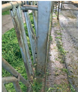
MIT DEM EINSTREUGERÄT werden die Liegeboxen befüllt. Die Säulen sind auf die Barrenmauer aufgesetzt um keine schmutzigen Ecken zu haben.
