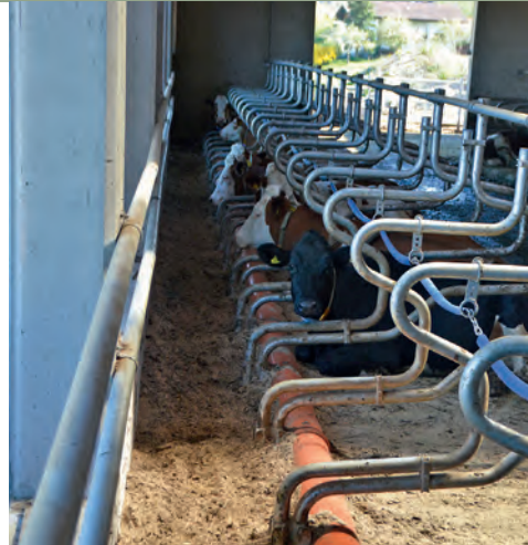
FÜR GENÜGENDE PLATZ BEIM LIEGEN sorgt ein kleiner Gang zwischen Wand und Liegebox.
