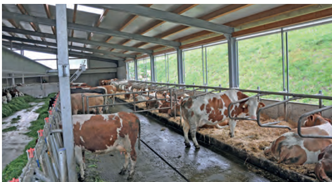
DER NEUE MILCHVIEHSTALL ist mit 58 Liegeboxen und 67 Fressplätzen gebaut. Trotz nordseitigen Anbaus ist der Stall extrem hell und luftig.
