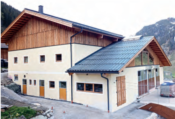
DER ALTE STALL wurde zur Gänze abgerissen und das neue Projekt am selben Standort umgesetzt.
