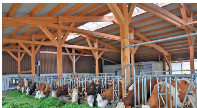
DIE HALLENKONSTRUKTION setzten die gelernten Zimmerer in der Familie nahezu selbst um.
