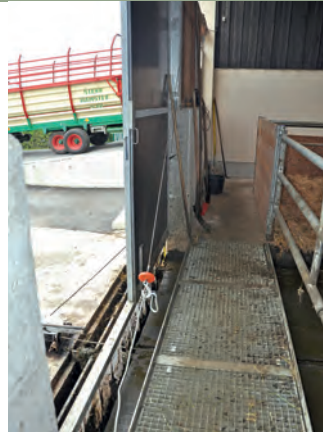
DER SAUBERGANG über der Schraperbahn ist mit einem Seilzug leicht zu entfernen.
