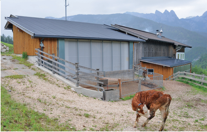
FÜR DEN KALBINNENSTALL wurde ein überdachter Fahrсило genützt. Die betonierte Seitenwand wurde aufgeschnitten, von der Firma Fernsehner der Unterbau gemacht und eine Holzdecke eingezogen. Das Obergeschoß wird als Stroh- und Futterlager genützt, der einfache Abwurf erleichtert die Arbeit.
