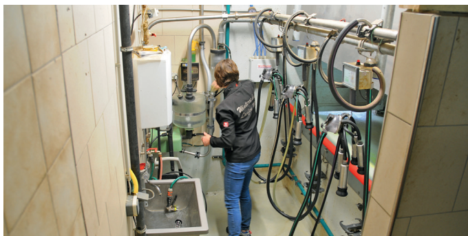
DER DREIER-SIDE-BY-SIDE-MELKSTAND war platztechnisch die einfachste Lösung, die Melktechnik wurde von der bestehenden Rohrmelkanlage übernommen. Die Kosten sind damit im Rahmen geblieben, der Arbeitskomfort ist deutlich gestiegen.
