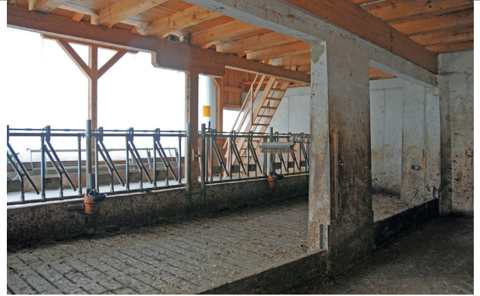
FÜR DEN KALBINNENSTALL wurde ein überdachter Fahrсило genützt. Die betonierte Seitenwand wurde aufgeschnitten, von der Firma Fernsehner der Unterbau gemacht und eine Holzdecke eingezogen. Das Obergeschoß wird als Stroh- und Futterlager genützt, der einfache Abwurf erleichtert die Arbeit.
